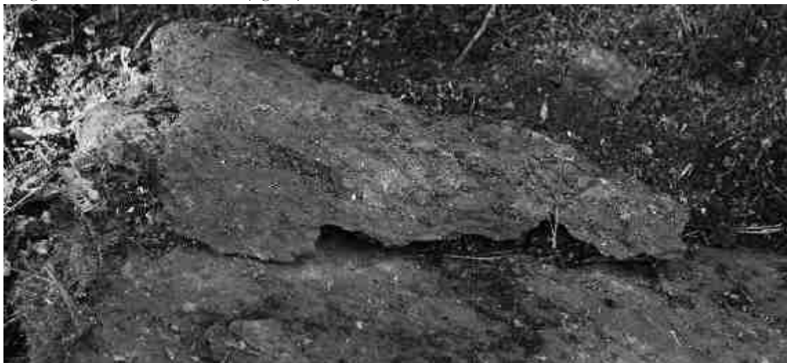
Figure 30 – Exemple de surface écaillée (Cliché A. Horrie)
