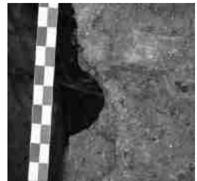
Figure 32 – le chant de ce bloc comporte une encoche qui est le négatif d'une boîte de débitage
