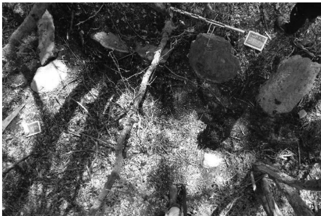
Figure 71 – Photo de monolithes ré employés pour border un fossé de drainage de zone humide
