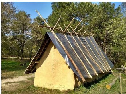
Un état des lieux de la maison a été réalisé par un charpentier, afin de déterminer l'intérêt de réparer ce bâtiment, dont la construction a débuté en 2005. Les éléments porteurs de la maison étant en bon état, un plan de sauvetage de la maison a été conçu, afin de mettre la charpente hors d'eau, tout en assurant la sécurité du public. Il a fallu trouver un intervenant spécialisé dans ce domaine.
