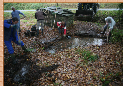
Chantier restauration du patrimoine
